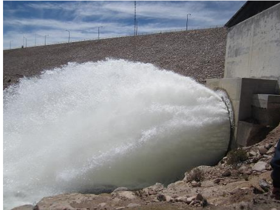
Compuerta de descarga de embalse de Pillones
