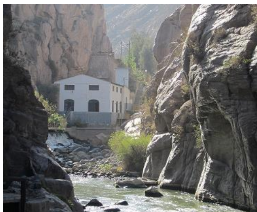
Vista de la Central Charcani II
