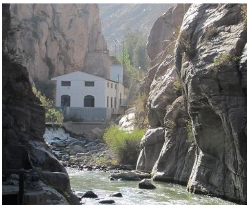
Vista de la Central Charcani II
