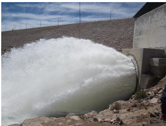
Compuerta de descarga de embalse de Pillones
