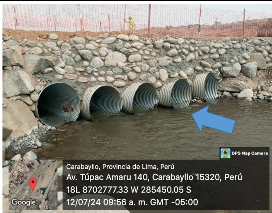
**Foto 03:** Vista frontal, El puente provisional se encuentra asentada sobre una alcantarilla conformada por 05 tuberías de TMC DE 48 pulgadas, por donde circula el recurso hídrico del río chillón con normalidad, no se verifica algún tipo de afectación hacia la fuente natural.
