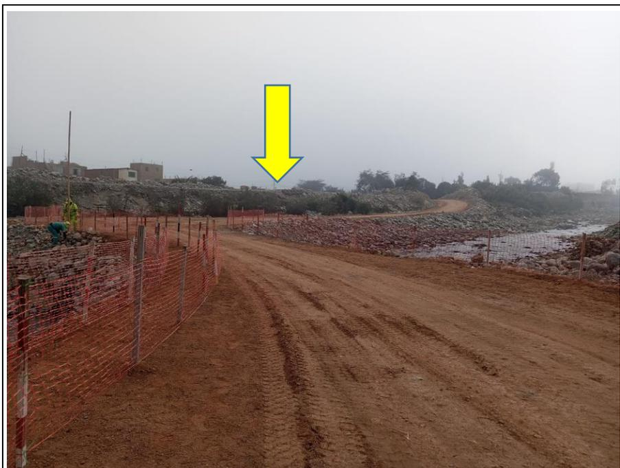
**Foto 02:** Se verifica que al momento de la presente verificación de campo se ha evidenciado la construcción del pase provisional de 40 metros de largo por 6.00 m de ancho aprox., el mismo que se encuentra acentuado sobre una alcantarilla.
