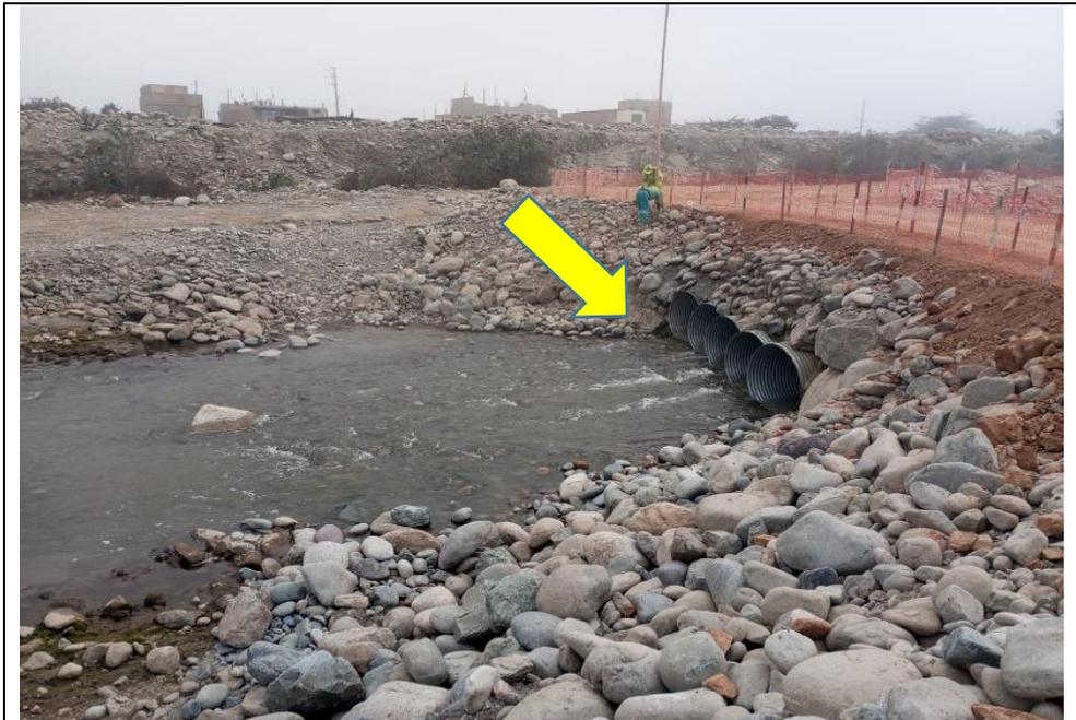
**Foto 04:** Vista posterior, se verifica que en la salida del recurso hídrico fluye con normalidad, no se genera acumulación.
