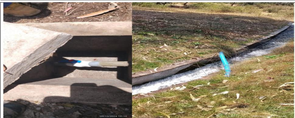
**Fotografía 9:** Vista de válvula de control y manguera HDPE de conducción hacia zona de uso.
