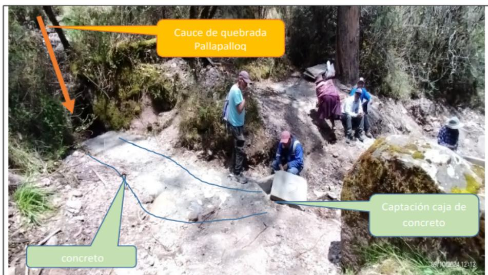
**Fotografía 1:** Vista zona de captación con material de concreto en cauce de quebrada Pallapalloq, en el distrito de Huamanguilla, provincia de Huanta, de departamento de Ayacucho.
