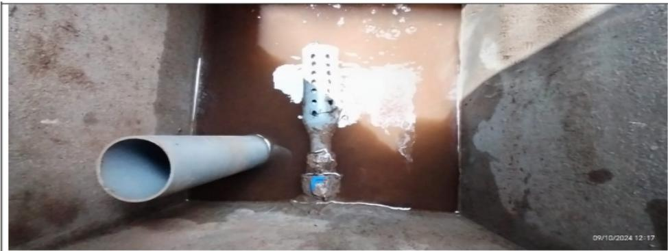
**Fotografía 4:** Vista de interior de caja de captación de concreto de aguas de afloramiento en cauce de quebrada Pallapalloq.
